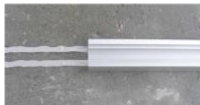
Lepljenje aluminija na beton
