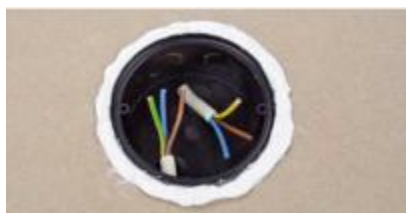
Pritrditev električnih polj v steno
