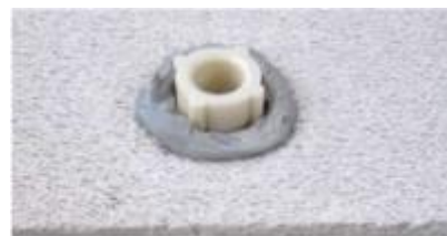
Lepljenje nastavkov v beton
