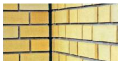
Tesnjenje fug pri opečnem zidu
