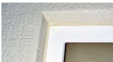
Zatesnitev okenskega okvirja od zunaj
